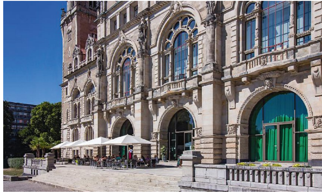
Gartensaal (Foto: Der Gartensaal)
